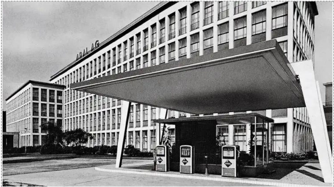
Quelle: ARAL AG – Hauptgebäude 60er Jahre
